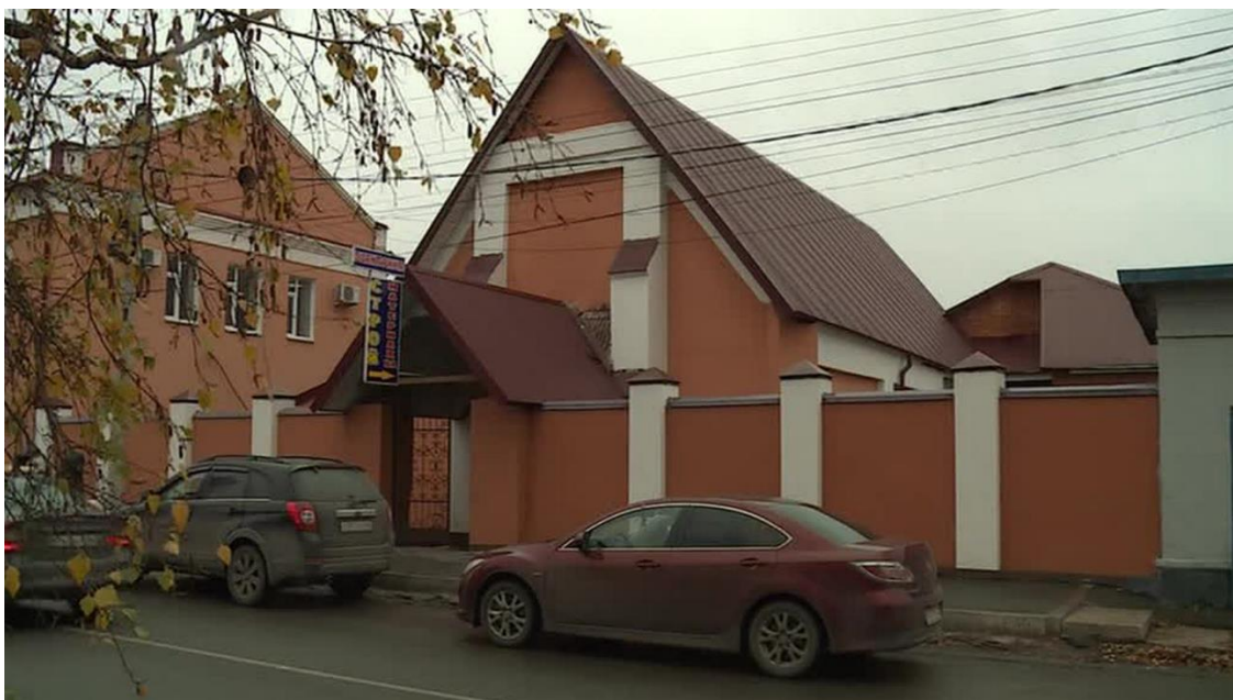
Рисунок 3 – здание кирхи после «ремонта»
